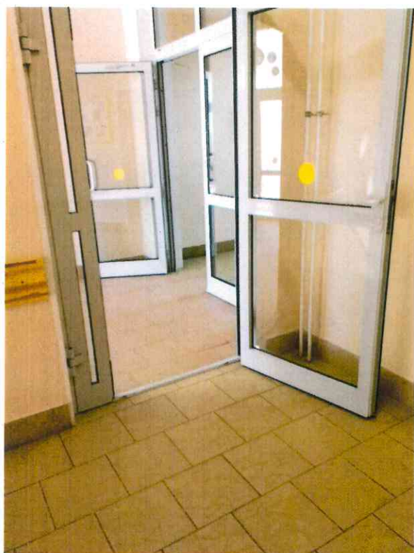
Выход на лестничный пролёт
