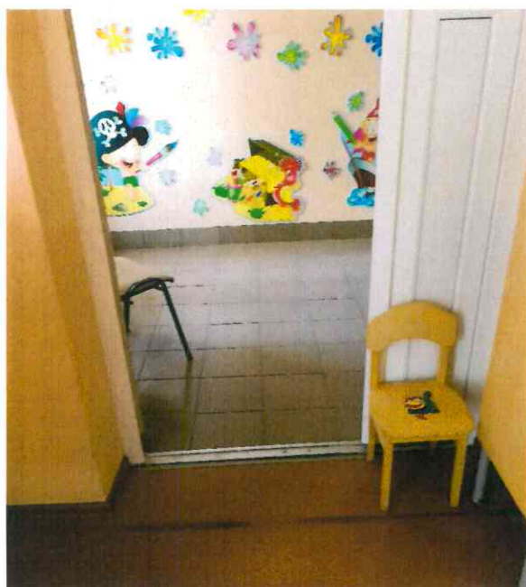
Выход на лестничный пролёт
